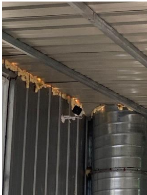
危废仓库内摄像头
